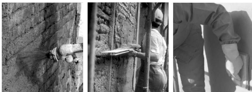
Figura 1: fasi di realizzazione di intonaco esterno (supporto, rivestimento e finitura)
