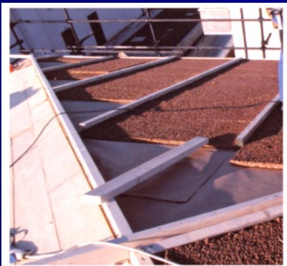
Pannelli di sughero 10 cm copertura
