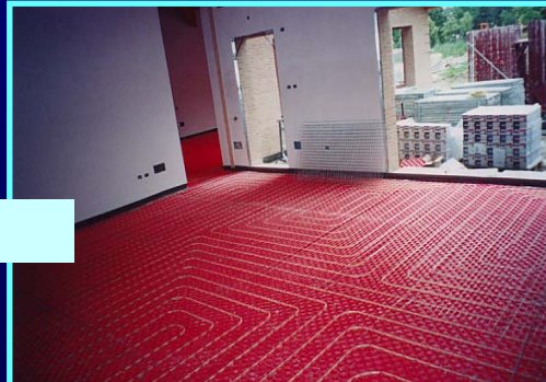
Isolamento Solaio contro terra: Pannelli di Polistirene
